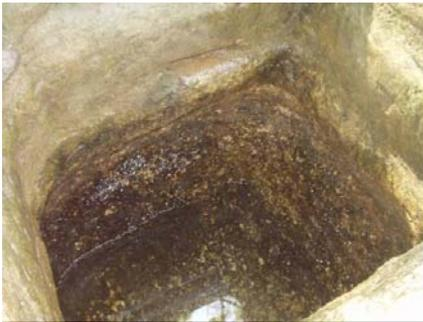
Fotografía 9.4.- Pozo n° 3. Pozo excavado a 10 m del río Acelhuate. El agua sale de las paredes de la toba volcánica. De este pozo se abastece el norte del municipio en época seca
