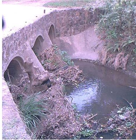
*Fotografía 8.11.- Acumulación de material en las secciones de los puentes.*
